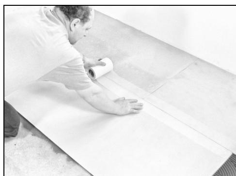
Spáry se upravují výztužnou perlínkovou páskou. Položte pásku, naneste flexibilní tmel, přebytek hmoty roztahněte hladítkem, popřípadě odstraňte. Přesah pásky musí být min. 50mm. Lepící hmotu nechte vytvrdnout dle návodu k použití.
