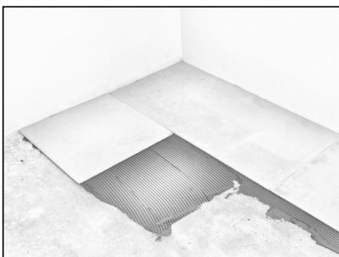
Při lepení na dřevěné a objemově nestále podklady musí být lepící tmel dostatečně flexibilní. Pro tento účel doporučujeme použít F-board 10. U těchto podkladů doporučujeme desky kotvit nejméně 4 kotvami osazenými min. 30 mm od hrany desky.
