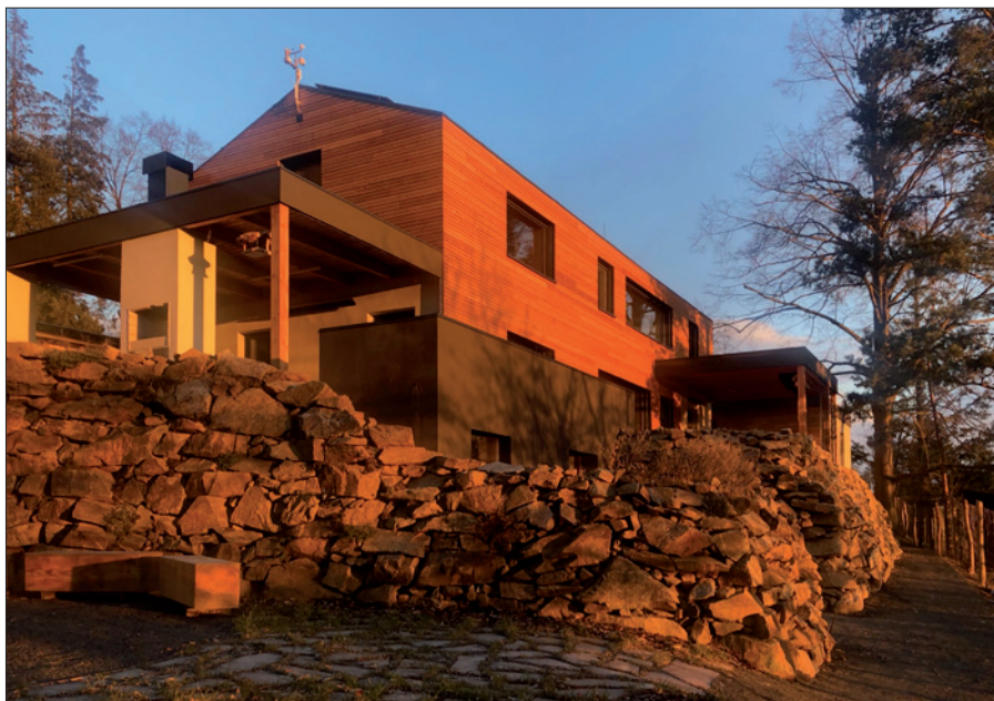
Obr. 1. Nový rodinný dům vyrostl za osm měsíců ve svahu v Omicích u Brna. Dům je projektován a vybaven tak, aby plnil a splnil požadavky a představy investora, který je zároveň i jeho uživatelem. Přitom je třeba, aby dům zároveň zastával i roli testovacího objektu projektu Národního centra kompetence CAMEB (TAČR), jehož nositelem je Univerzitní centrum energeticky efektivních budov ČVUT (UCEEB). Řízení osvětlení a a nadřazenou koordinaci všech technologií zde zajišťuje řídicí systém Tecomat Foxtrot firmy Teco a.s.
