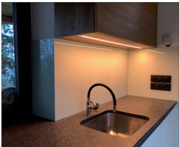
Obr. 13. Osvětlení kuchyňské linky zabudovanými LED pásky
