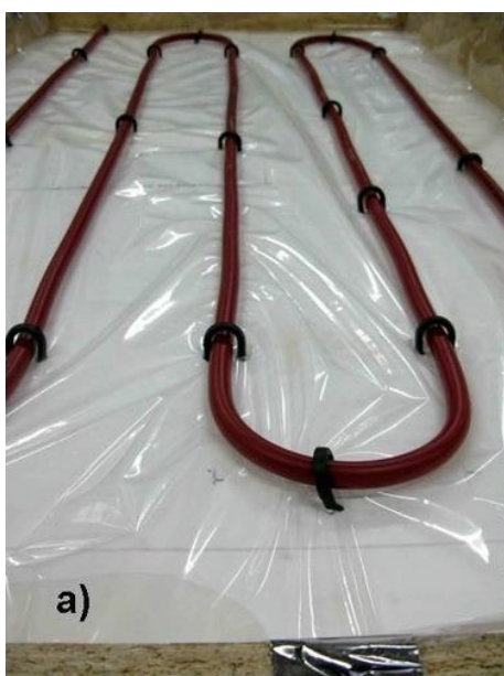
Obr. 2 Detail upevnění otopného hadu plastovými sponami: vlevo – PE fólie; vpravo – termoreflexní fólie
